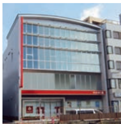
尾久支店 (平成24年9月リニューアルオープン)
